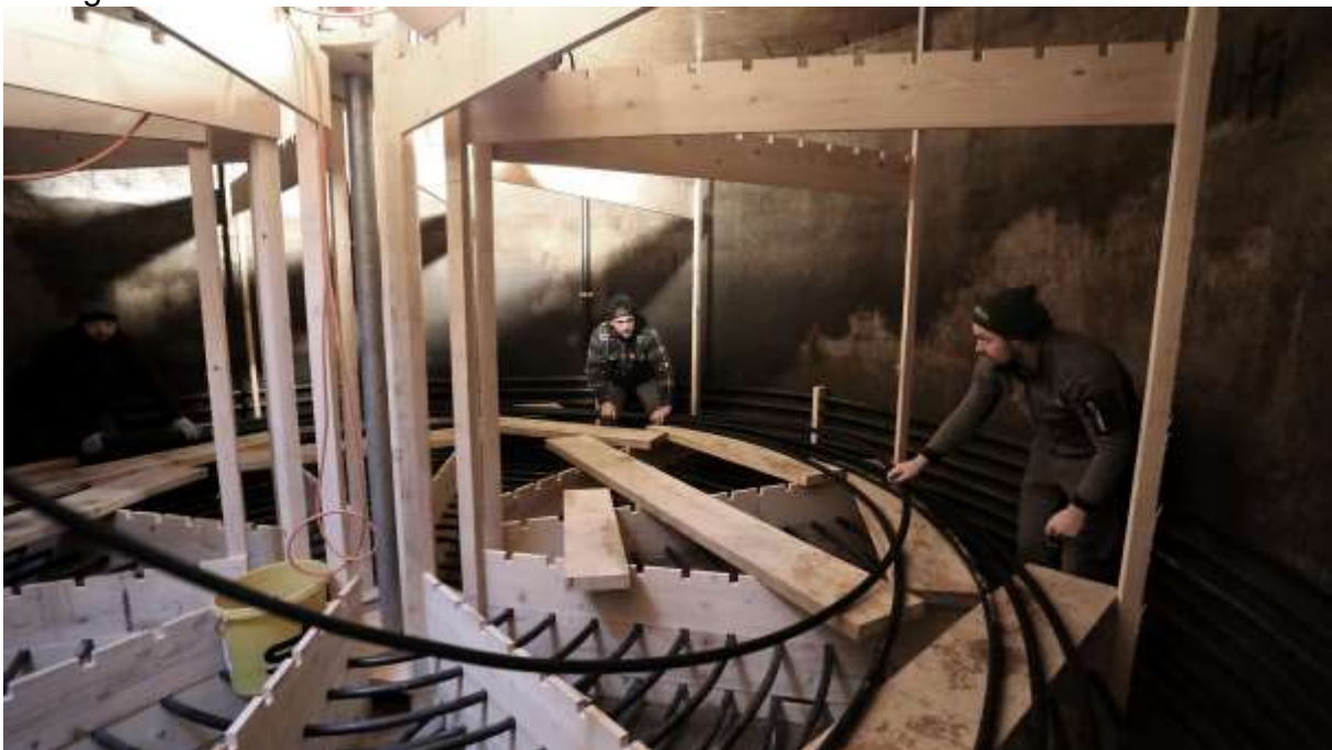
Georg Bechter Durch den Wechsel der Aggregatzustände von Wasser entsteht hier später Energie zum Heizen Bild 5 von 5
