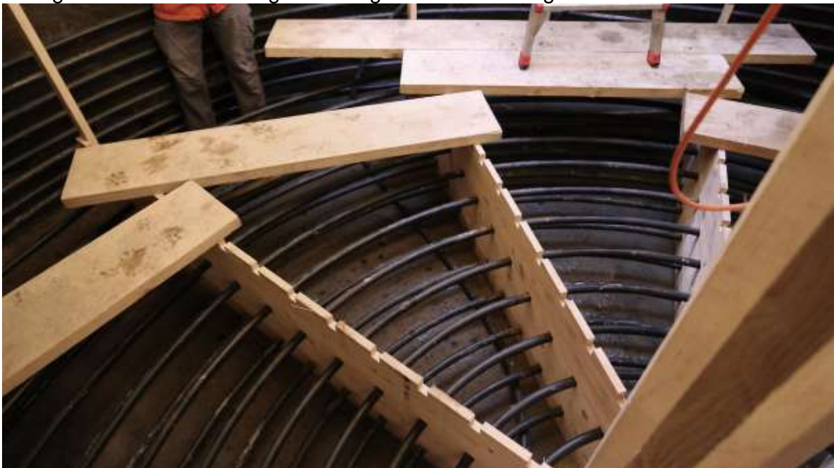
Georg Bechter In der ehemalige Kellergrube entsteht die neue Heizung
